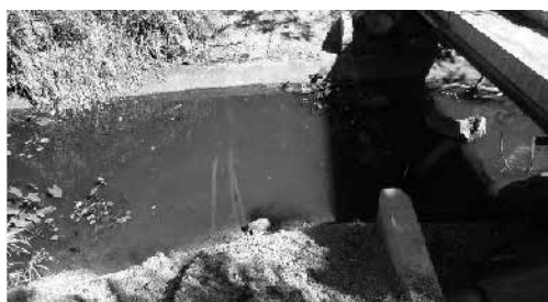
写真4 人道橋整備現場の検査
