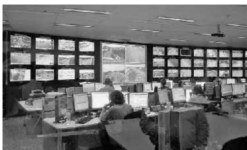
BMTMCの管制室
