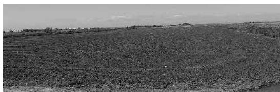
広大な西下水処理場の汚泥天日乾燥エリア
